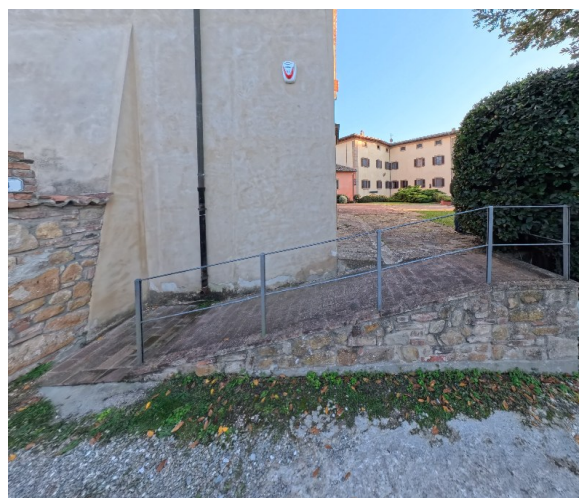
6 rampa laterale Chiesa
